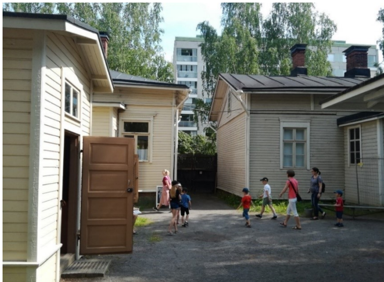
Kuva 14: Näkymä Amurin työläismuseokorttelin sisäpihalta. Taustalla on Amurinkujan vuonna 1971 rakennettu elementtikerrostalo.
