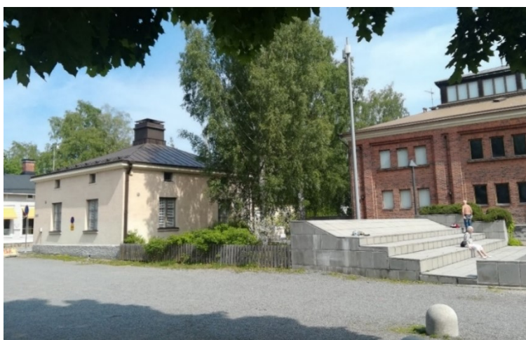
Kuva 13: Taidemuseon piharakennus rakennettiin vuonna 1930 museon vahtimestarin asunnoksi, ja rakennuksen kellarikerrokseen sijoitettiin museon lämpökeskus. Rakennus muutettiin museon toimistotilaksi vuonna 1979.
